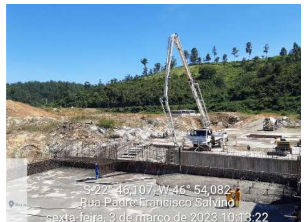
Foto 193 – Vista geral das atividades construtivas da fundação. (Data:03/03/2023)
