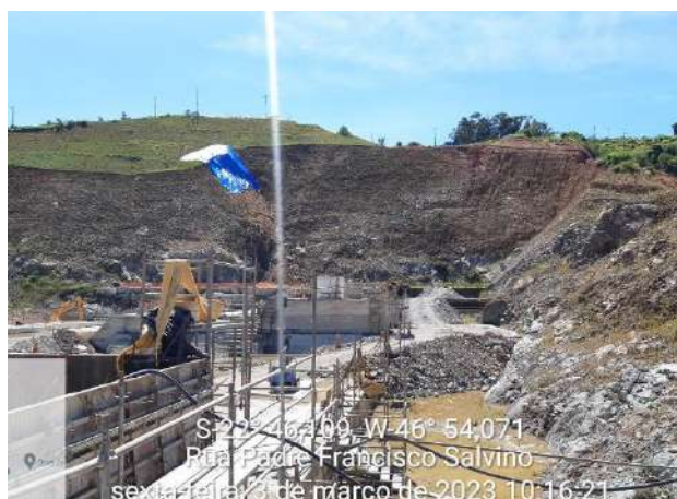
Foto 194 – Vista geral das atividades construtivas da fundação. (Data:03/03/2023)
