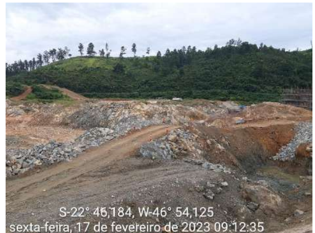
Foto 189 – Vista geral das atividades construtivas da fundação. (Data:17/02/2023)
