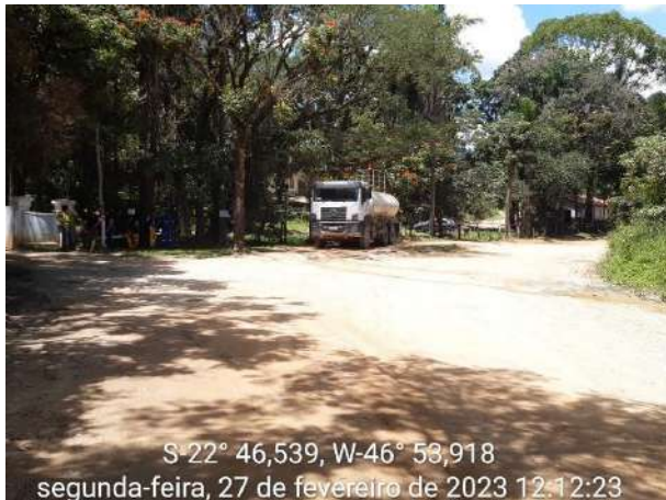
Foto 166 – Realização da umectação das vias externas. (Data:27/02/2023)
