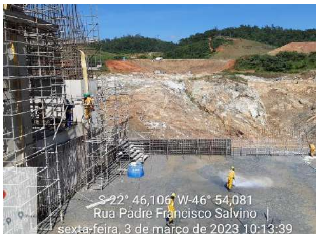
Foto 192 – Vista geral das atividades construtivas da fundação. (Data:03/03/2023)
