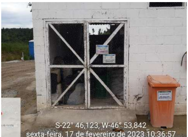
Foto 43 – Limpeza e organização local nos arredores da usina (Data:17/02/2023)
