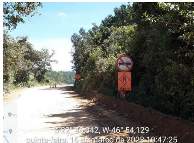
Foto 121 – Sinalização vertical implantada na via interna da obra. (Data:16/03/2023)
