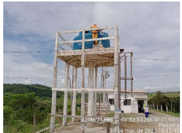
Foto 57 – Adequação de dosagem de cloro na caixa de água disposta na frente de serviço. (Data:14/03/2023)
