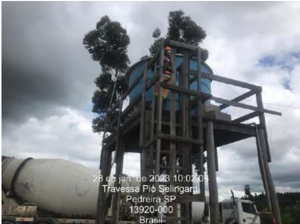
Foto 49– Adequação de dosagem de cloro na caixa de água disposta na frente de serviço. (Data:28/01/2023)
