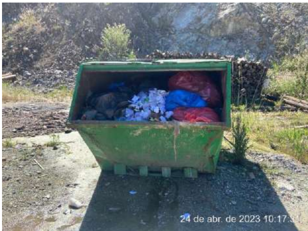
Foto 182 – Caçamba de resíduo comum do canteiro da fundação. (Data:24/04/2023)
