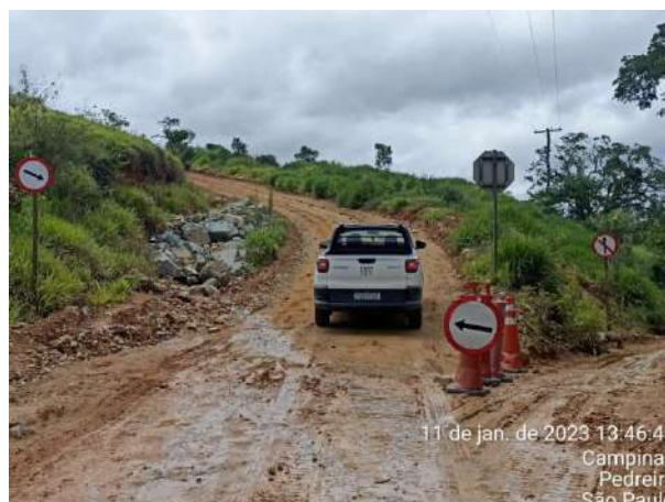
Foto 102 – Sinalização vertical implantada na via externa da obra. (Data:11/01/2023)
