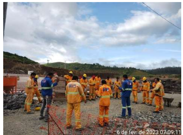
Foto 95 – DDS realizado com as equipes na frente de serviço. (Data:06/02/2023)
