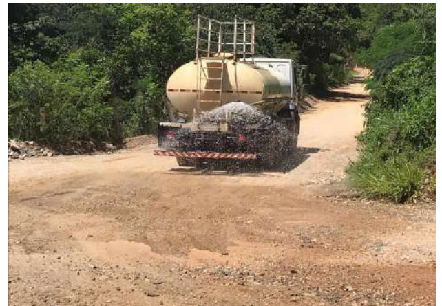
Foto 163 – Realização da umectação das vias externas. (Data:17/01/2023)
