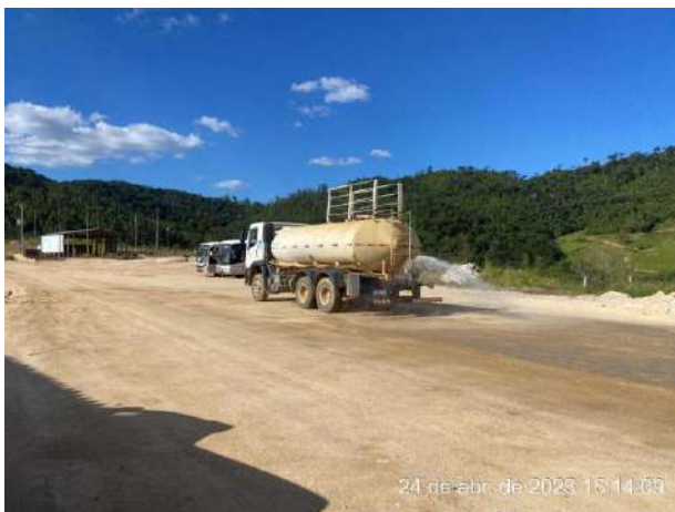
Foto 170 – Realização da umectação das vias externas. (Data:09/04/2023)
