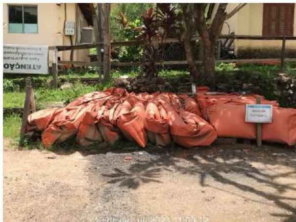
Foto 31 - Kit de emergência ambiental no canteiro administrativo. (Data:13/01/2023)
