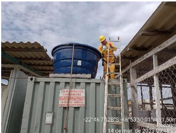
Foto 56 – Adequação de dosagem de cloro na caixa de água disposta na Usina de Concreto. (Data:14/03/2023)
