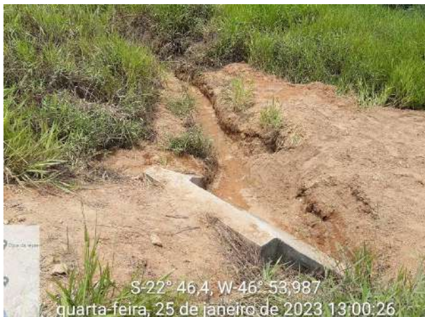
Foto 128 – Passagem de drenagem implantada na estrada de acesso ao empreendimento. (Data:25/01/2023)
