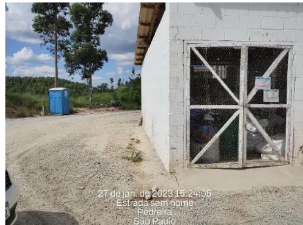
Foto 39– Limpeza e organização local nos arredores da usina (Data:27/01/2023)
