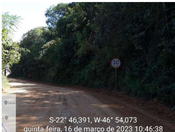
Foto 120 – Sinalização vertical implantada em via interna. (Data:16/03/2023)
