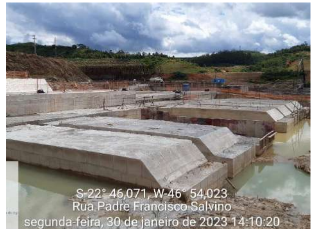
Foto 185 – Vista geral das atividades construtivas da fundação. (Data:30/01/2023)
