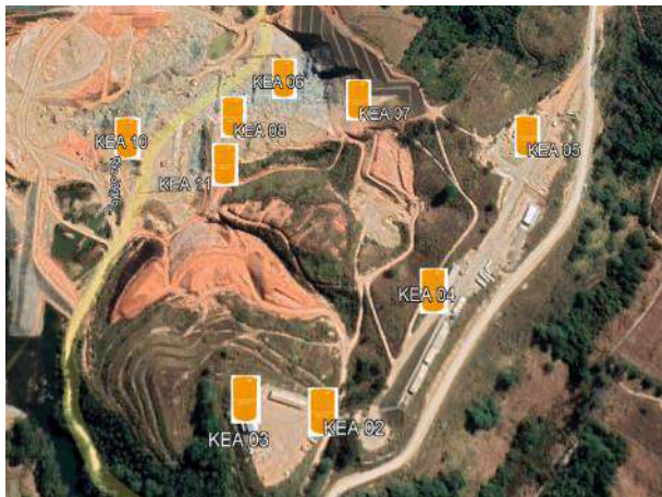
Figura 3 – Indicação dos kits de emergência ambiental na margem direita.
