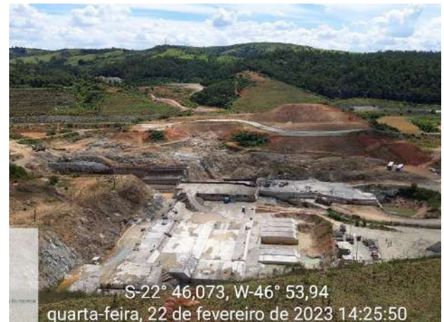
Foto 191 – Vista geral das atividades construtivas da fundação. (Data:22/02/2023)
