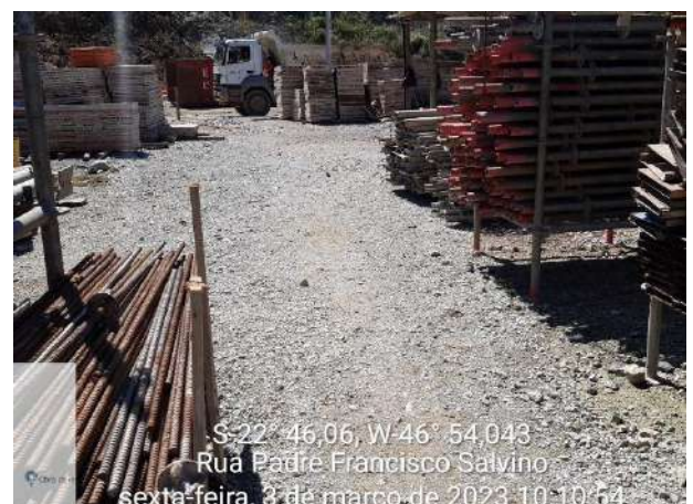
Foto 45 – Limpeza e organização na área de armazenamento de ferragens. (Data:03/03/2023)
