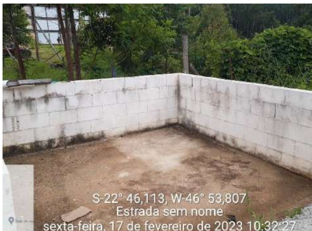
Foto 42 – Limpeza e organização na baía da usina de concreto. (Data:17/02/2023)
