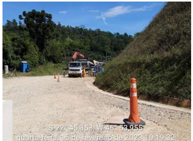
Foto 113 – Sinalização vertical implantada na via externa da obra. (Data:15/02/2023)
