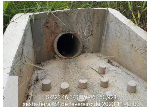
Foto 133 – Passagem de drenagem implantada na estrada de acesso ao empreendimento. (Data:24/02/2023)
