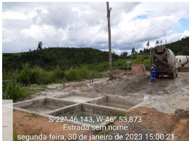
Foto 142 – Sistema de Tratamento de Efluentes utilizado para coleta de resíduos de concreto das betoneiras. (Data:30/01/2023)
