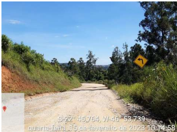
Foto 106 – Sinalização vertical implantada em via externa. (Data:15/02/2023)
