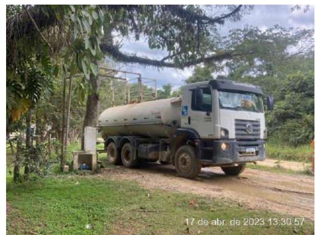
Foto 171 – Realização da umectação das vias internas. (Data:16/04/2023)
