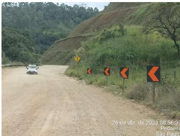
Foto 124 – Sinalização vertical implantada na via interna da obra. (Data:26/04/2023)
