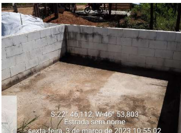
Foto 46 – Limpeza e organização na baia da usina de concreto. (Data:03/03/2023)
