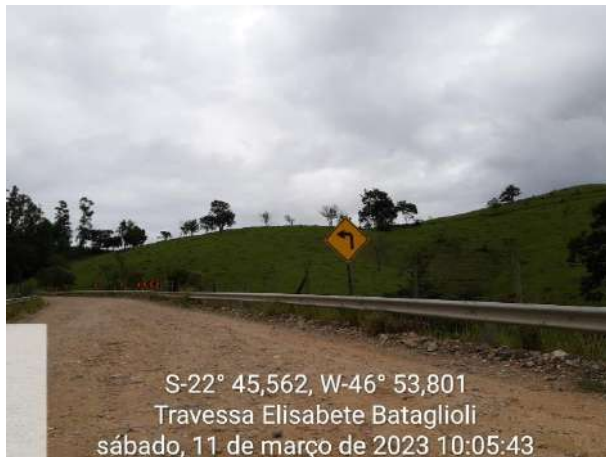
Foto 116 – Sinalização vertical implantada em via externa. (Data:11/03/2023)
