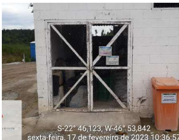
Foto 21 – Vista geral da baia de armazenamento de Produtos Perigosos na oficina mecânica. (Data:17/02/2023)
