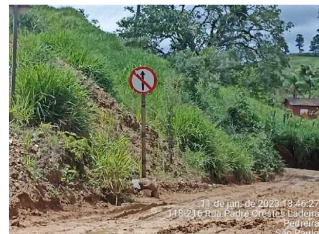
Foto 103 – Sinalização vertical implantada na via externa da obra. (Data:11/01/2023)
