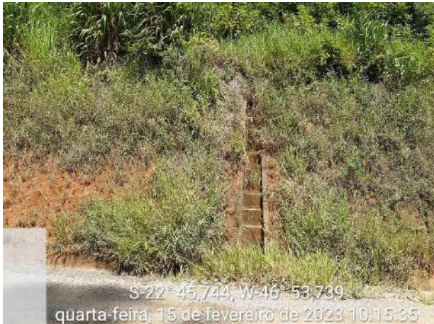
Foto 130 – Escada hidráulica implantada na estrada de acesso ao empreendimento. (Data:15/02/2023)
