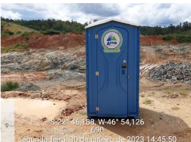
Foto 152 – Vista do sanitário químico disponível na frente de serviço. (Data:30/01/2023)
