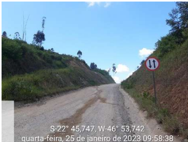
Foto 98 – Sinalização vertical implantada em via externa. (Data:25/01/2023)
