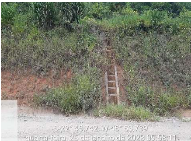
Foto 126 – Escada hidráulica implantada na estrada de acesso ao empreendimento. (Data:25/01/2023)
