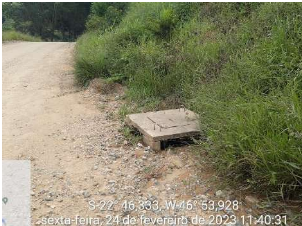
Foto 132 – Passagem de drenagem implantada na estrada de acesso ao empreendimento. (Data:24/02/2023)
