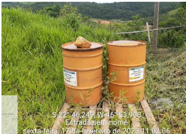
Foto 32 – Kit de emergência ambiental no canteiro industrial. (Data:17/02/2023)
