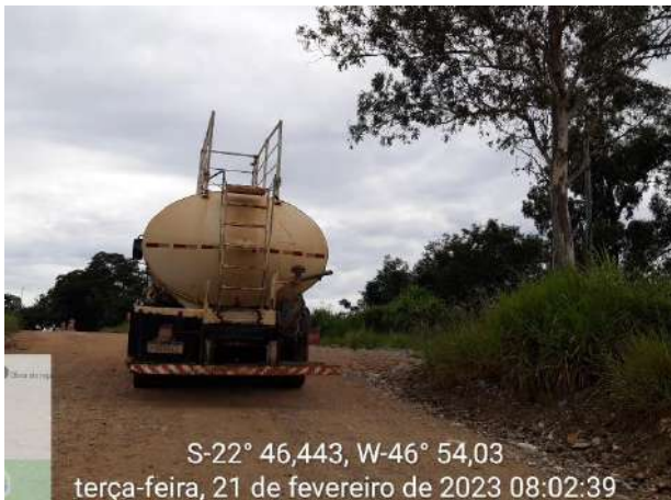
Foto 168 – Realização da umectação nas vias internas. (Data:21/02/2023)
