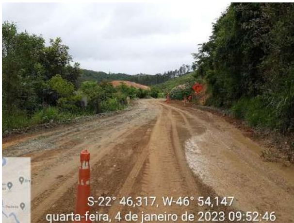
Foto 104 – Sinalização vertical implantada na via interna da obra. (Data:04/01/2023)
