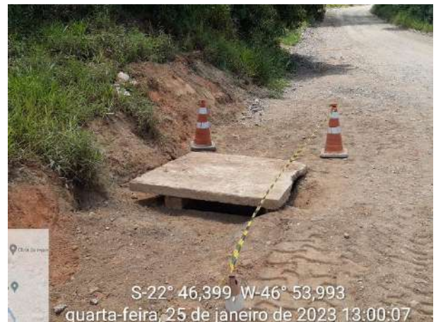
Foto 127 – Caixa de drenagem implantada na estrada de acesso ao empreendimento. (Data:25/01/2023)
