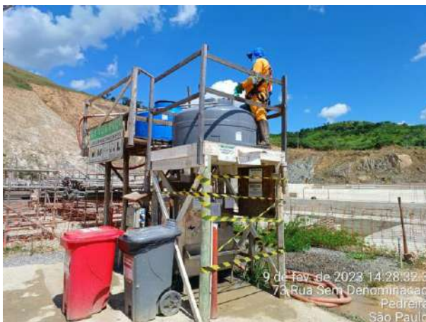
Foto 52 – Adequação de dosagem de cloro na caixa de água disposta na frente de serviço. (Data:09/02/2023)
