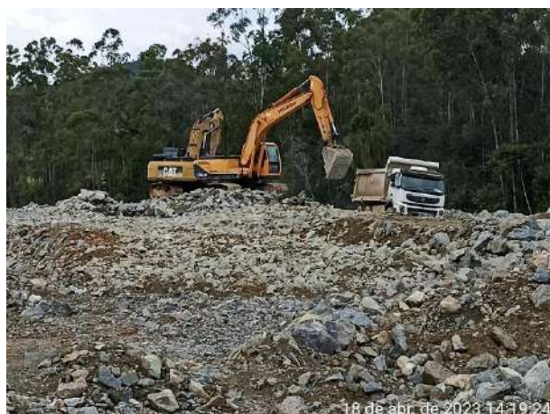
Foto 196 – Vista geral das atividades construtivas da fundação. (Data:18/04/2023)
