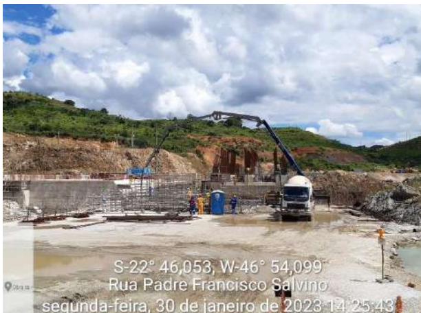
Foto 186 – Vista geral das atividades construtivas na frente de serviço da fundação. (Data:30/01/2023)
