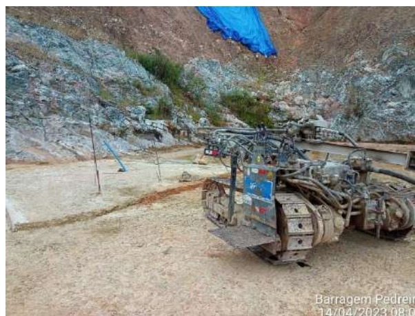
Foto 197 – Vista geral das atividades construtivas da fundação. (Data:14/04/2023)
