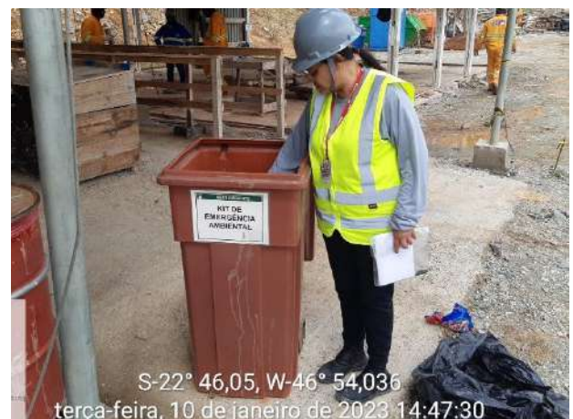
Foto 30 – Kit de emergência ambiental no canteiro da fundação. (Data:10/01/2023)
