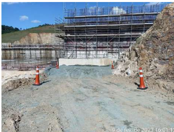
Foto 108 – Sinalização em cones implantada na via interna da obra. (Data:09/02/2023)
