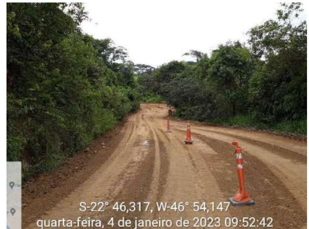
Foto 105 – Sinalização vertical implantada na via interna da obra. (Data:04/01/2023)
