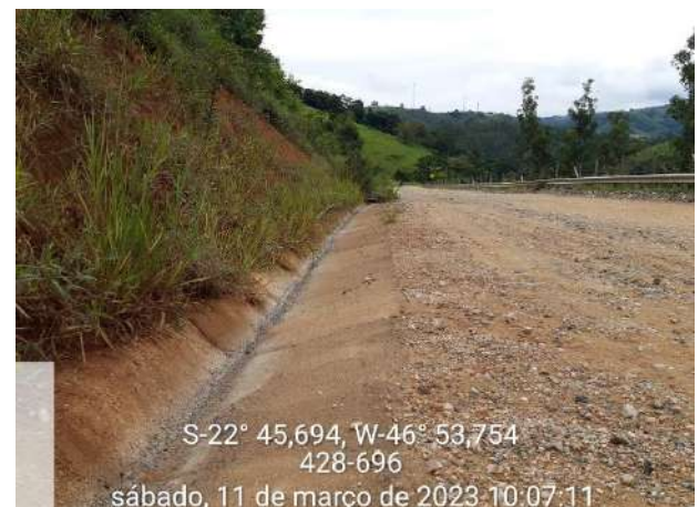
Foto 135 – Sistema de drenagem implantada na estrada de acesso ao empreendimento. (Data:11/03/2023)
