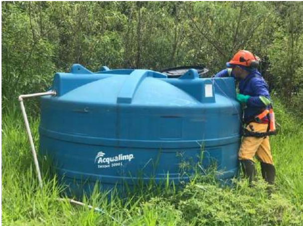
Foto 48– Adequação de dosagem de cloro na caixa de água disposta na frente de serviço. (Data:10/01/2023)
