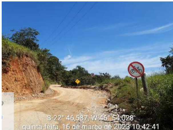
Foto 118 – Sinalização vertical implantada na via interna da obra. (Data:16/03/2023)
