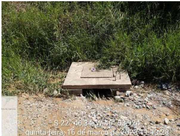
Foto 136 – Passagem de drenagem implantada na estrada de acesso ao empreendimento. (Data:16/03/2023)
