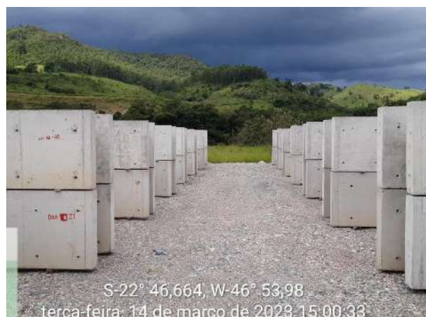
Foto 47 – Limpeza e organização na frente de trabalho do pré-moldados (Data:14/03/2023)
