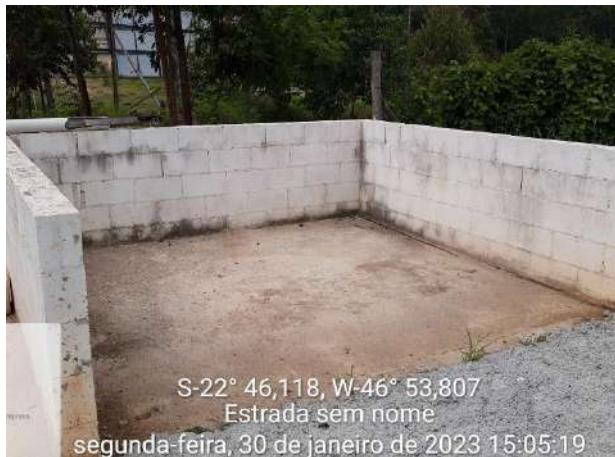
Foto 38– Limpeza e organização na baía da usina de concreto. (Data:30/01/2023)
