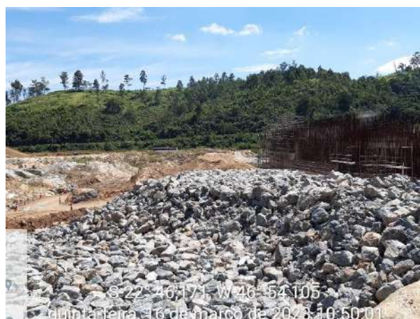
Foto 195 – Vista geral das atividades construtivas da fundação. (Data:16/03/2023)
