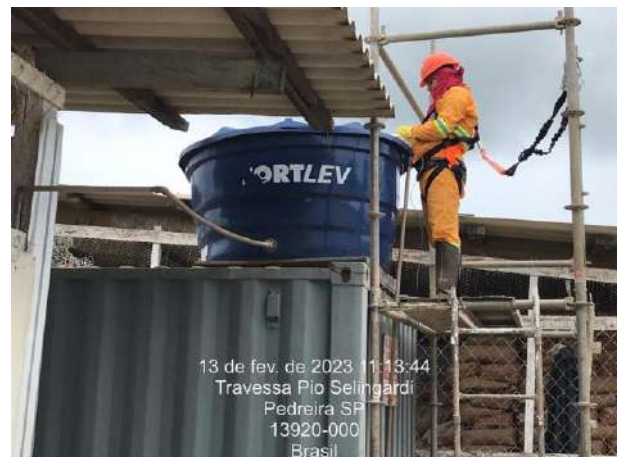
Foto 53 – Adequação de dosagem de cloro na caixa de água disposta na frente de serviço. (Data:13/02/2023)
