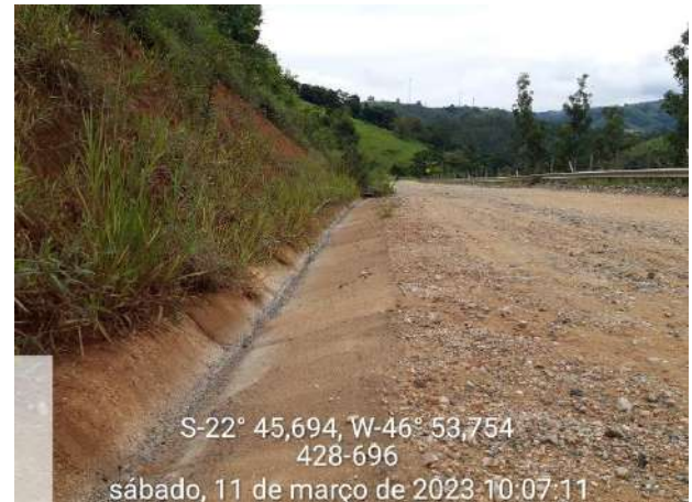
Foto 139 – Sistema de drenagem implantada na estrada de acesso ao empreendimento. (Data:11/04/2023)
