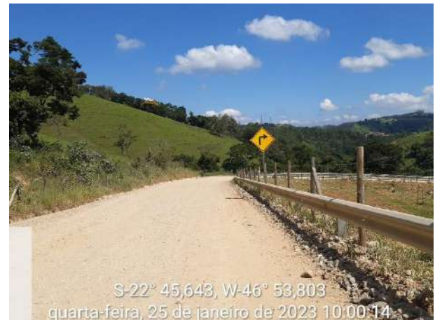
Foto 99 – Sinalização vertical implantada em via externa. (Data:25/01/2023)
