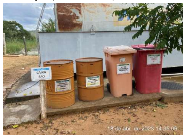
Foto 35 – Kit de emergência ambiental no canteiro da fundação. (Data:18/04/2023)
