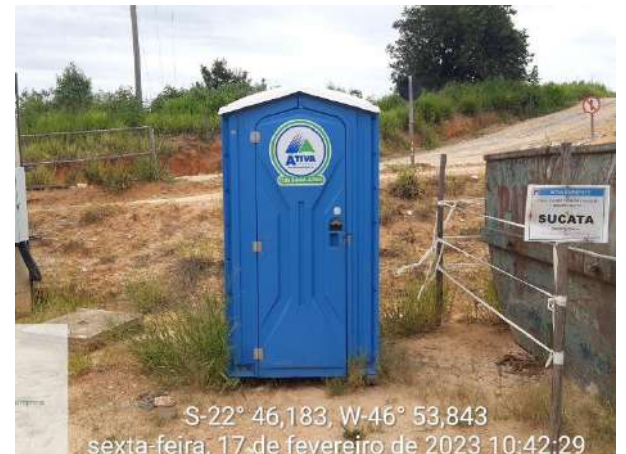
Foto 159 – Vista do sanitário químico disponível na frente de serviço. (Data:17/02/2023)
