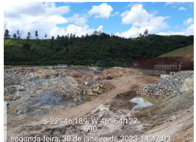
Foto 187 – Vista geral das atividades construtivas da fundação. (Data:30/01/2023)
