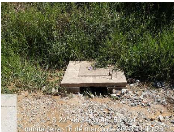
Foto 140 – Passagem de drenagem implantada na estrada de acesso ao empreendimento. (Data:16/04/2023)
