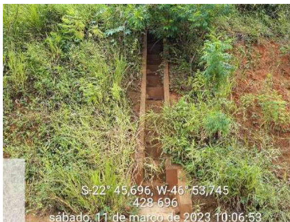
Foto 134 – Escada hidráulica implantada na estrada de acesso ao empreendimento. (Data:11/03/2023)
