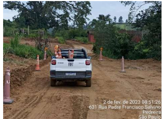
Foto 111 – Sinalização em cones implantada em via interna. (Data:02/02/2023)
