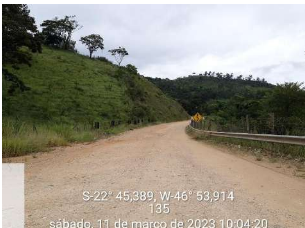
Foto 114 – Sinalização vertical implantada em via externa. (Data:11/03/2023)
