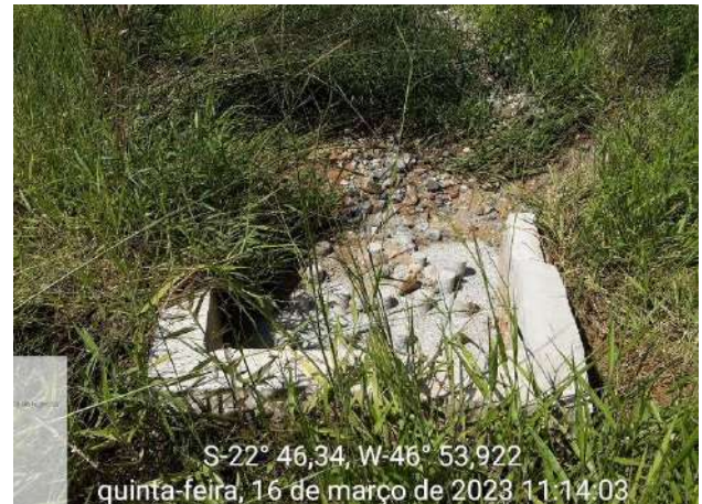
Foto 137 – Passagem de drenagem implantada na estrada de acesso ao empreendimento. (Data:16/03/2023)
