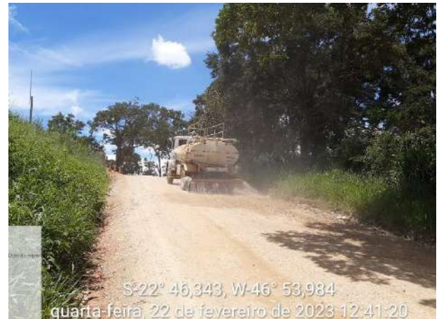
Foto 167 – Realização da umectação das vias internas. (Data:22/02/2023)
